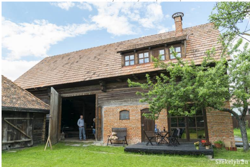
Hagyományos keresztcsűr átépítve lakó funkcióval, modern részletekkel
