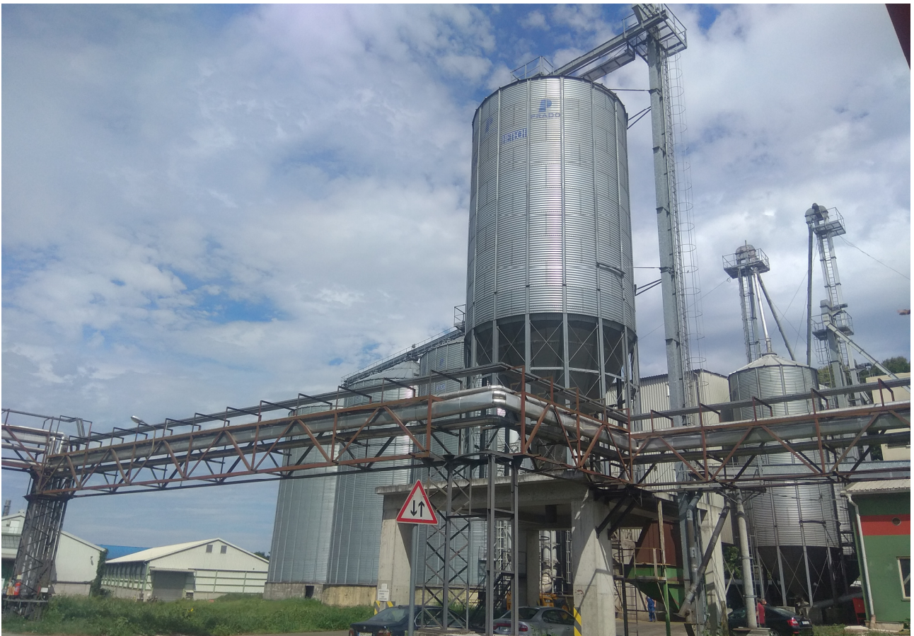
A terület hátsó részén meglévő silók és csőhidak
