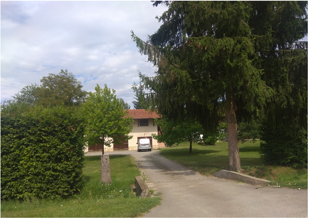
A meglévő szállásépület...
